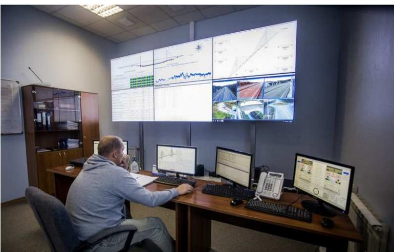
Приборный мониторинг всех элементов моста проводит отдельная диспетчерская группа. На вантовом мосту установлено огромное количество оборудования, в том числе более 500 различных датчиков. Такие показатели, как натяжение вант, метеорологические условия, скорость ветра, состояние дорожного движения и многие другие выводятся на экраны в центре мониторинга. За всеми процессами специалисты следят в реальном времени.
