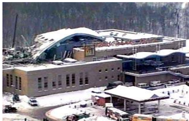
Рис. 3.2. Обрушение СОК «Трансвааль-Парк»
