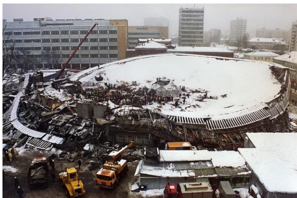
Рис. 3.1 Обрушение Басманного рынка
