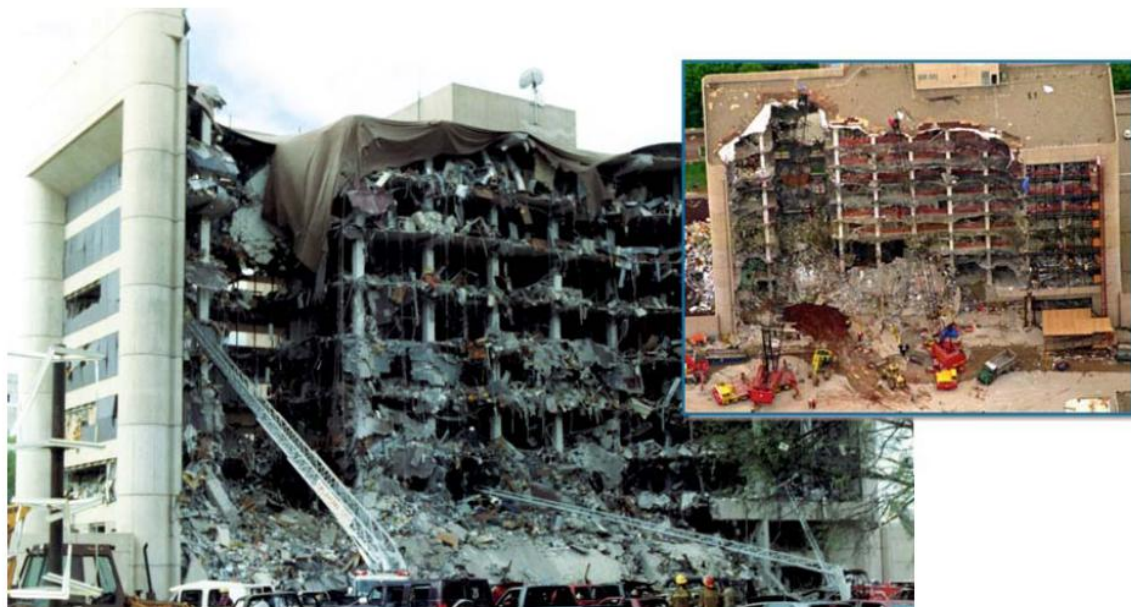
Рис.2.21. Взрыв в г. Оклахома, США, m_{\text{ТНТэкв}} = 2300 кг
