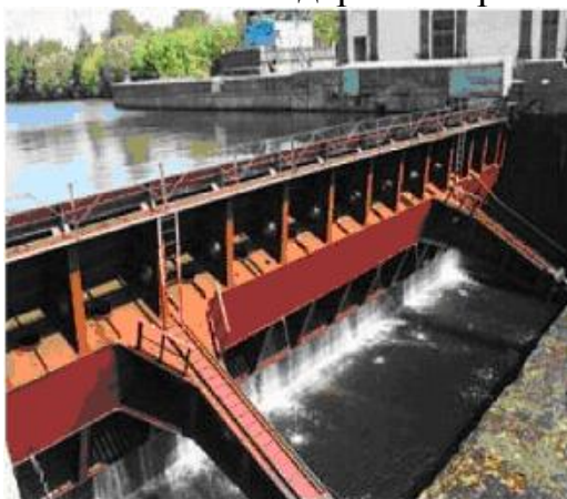
Рисунок 1 - общий вид конструкции шлюзового затвора
